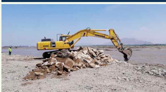
Reforzamiento en sector El Voladero
