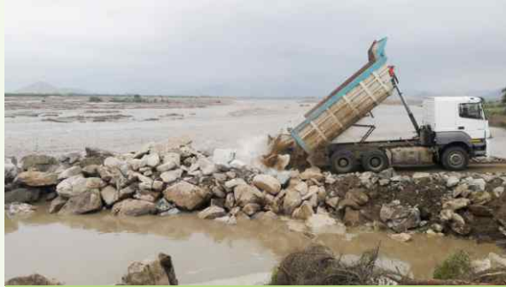
Enrocado en río Chicama
