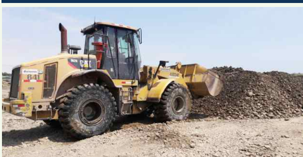
Trabajos en badén San Diego
