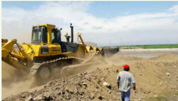
Reforzamiento en puente Nazareno
